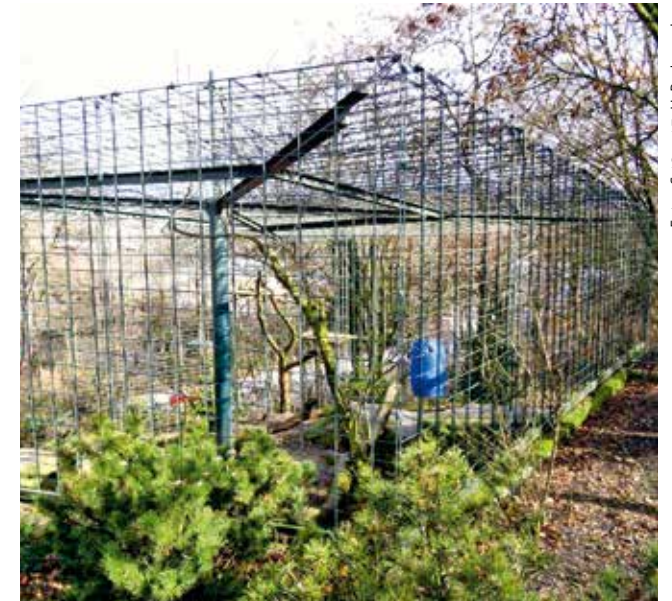
Die ehemalige Schneeleoparden-Anlage, die 2016 abgerissen wurde
