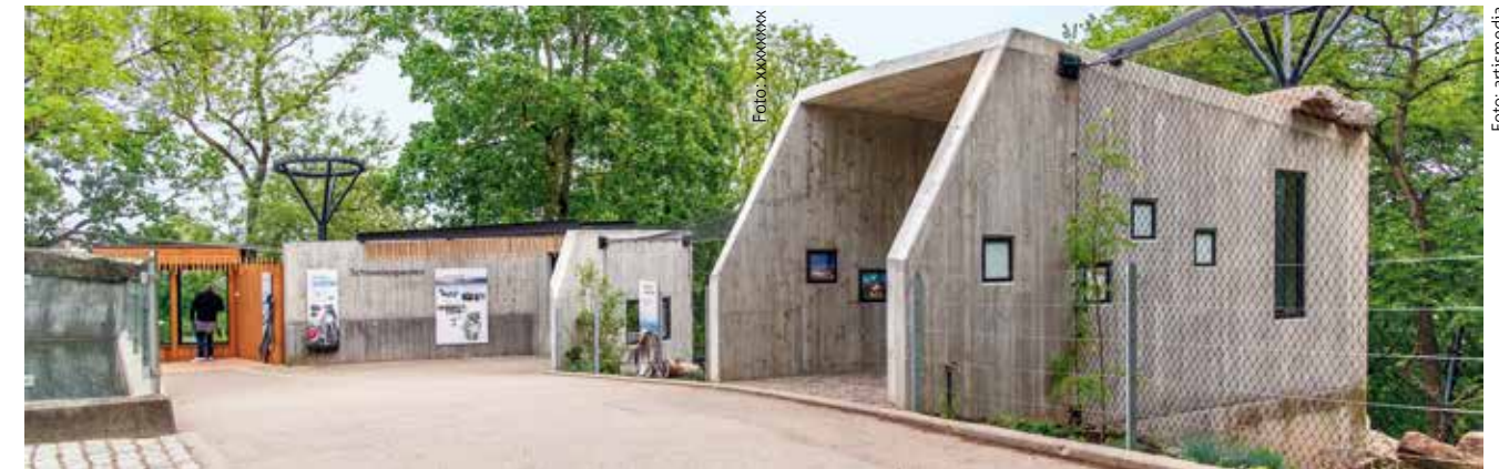
Blick vom Besucherweg auf die neue Anlage
