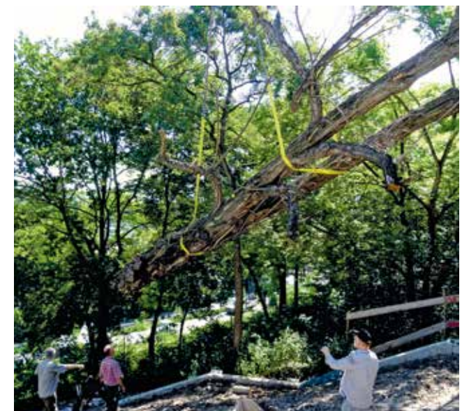
Ein Robinienstamm wird mit einem Schwerlastkran in das neue Gehege eingesetzt.
